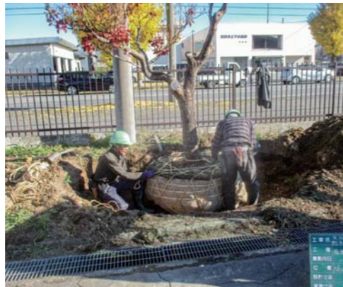
サラサドウダンの根巻き作業 (米沢市新庁舎)
